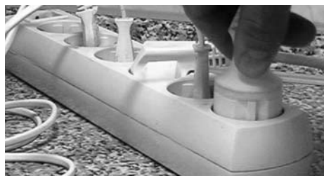
Пять электроприборов подсоединены к удлинителю. Существует опасность перегрузки электросети
